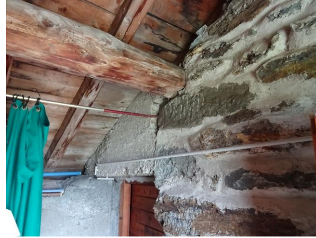
Détail Charpente bûcher (porte cave 1)
