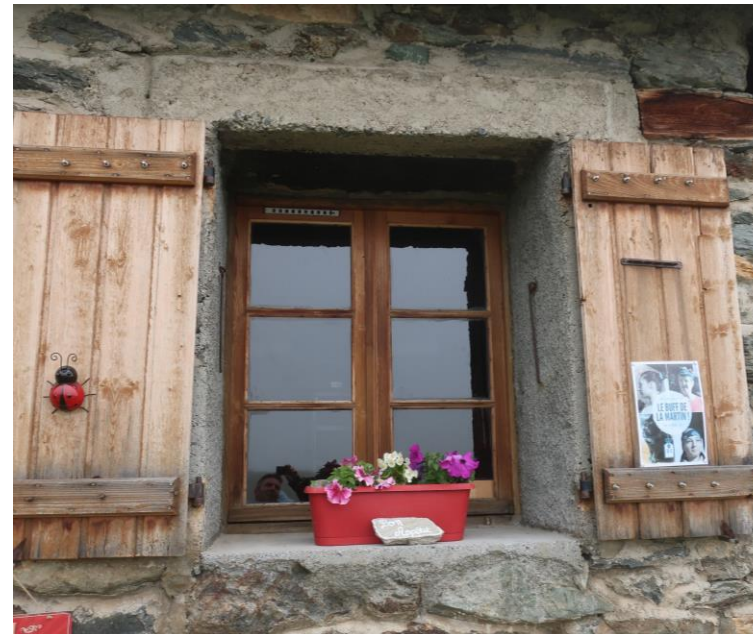
Fenêtre façade Sud
