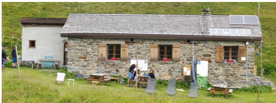
Vue extérieure – Façade Sud
