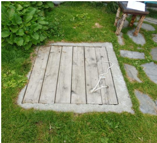
Regard d'arrivée et de distribution d'eau à déposer/déplacer
