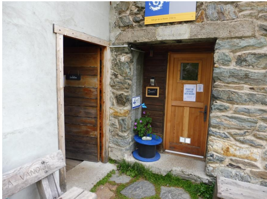
Portes Bûcher et entrée publique du refuge
