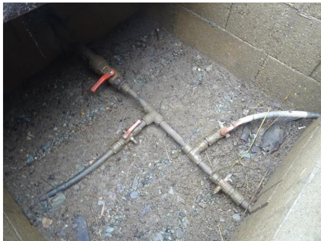
Regard d'arrivée et de distribution d'eau à déposer/déplacer
