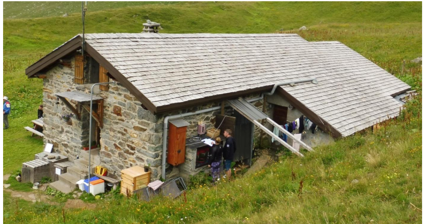
Vue extérieure - Angle Nord-Est
