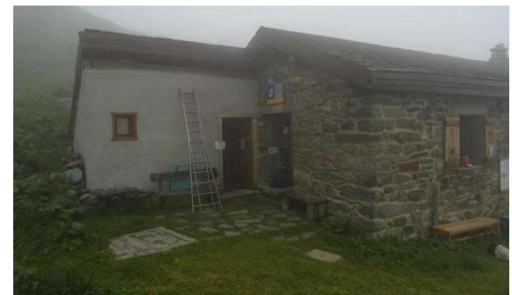
Emplacement de l'extension à réaliser
