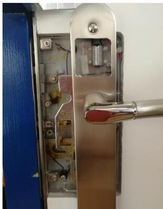
Le déverrouillage de la serrure est assuré par la commande d'un moteur permettant de lier la poignée extérieure au mécanisme. Le verrouillage se fait sur le même principe mais dans ce cas la poignée extérieure est libre (aucune action sur le mécanisme).
