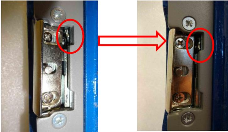
Lorsque la gâche électrique n'est plus utilisée, remettre le loquet en position haute.
