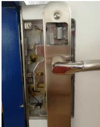
Pour autoriser à l'ouverture de la porte côté extérieur, l'actionneur doit être alimenté de manière brève. Le déverrouillage de la serrure est alors assuré par la commande d'un moteur permettant de lier la poignée extérieure au mécanisme. Le verrouillage se fait sur le même principe mais dans ce cas la poignée extérieure est libre (aucune action sur le mécanisme donc ouverture impossible).
